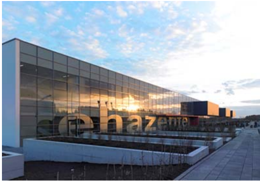
Bildtext Foto 1: Fassade mit Eingangsbereich
