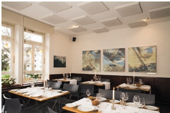
Schallschutz-Elemente (Melapor-Panels) in einem Restaurant sorgen für eine angenehme Akustik.
